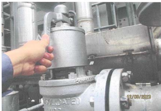
ตรวจสอบSafety Valve ต่างๆทำงานตามค่าที่กำหนด
