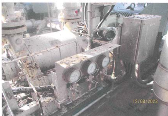
ตรวจสอบระบบ Feed Water Pump เข้าหม้อน้ำ
